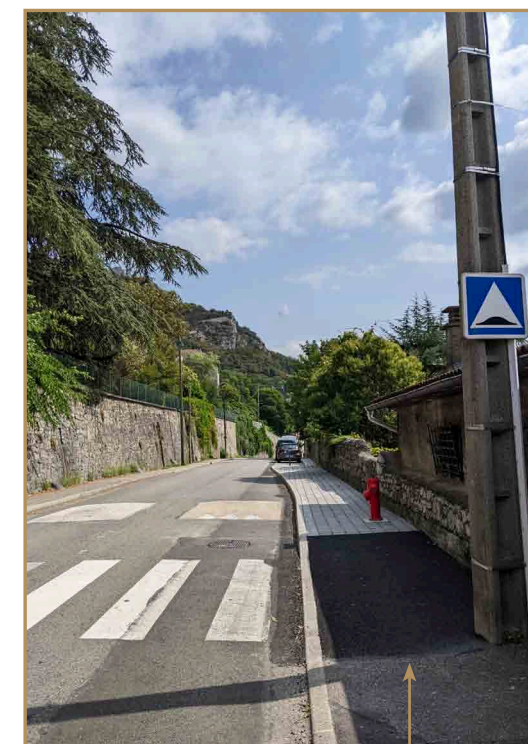
Construction d'un nouveau trottoir plus sécurisé
