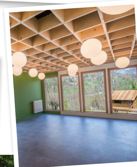
Le plafond à caissons et ses orbes de lumière
